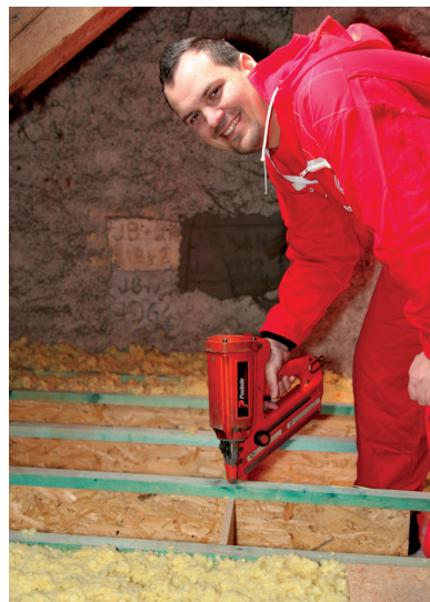
Montáž stropního systému Magmarelax s foukanou minerální izolací
