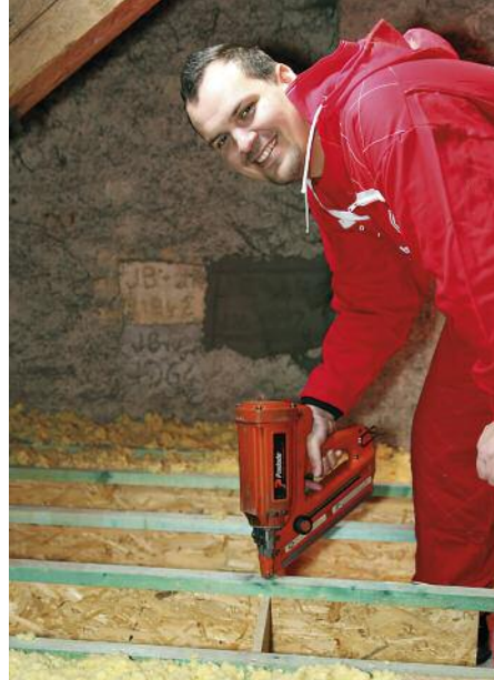
Pracovník IP Polná ukazuje základní rošt Stropního systému MAGMARELAX zafoukaný minerální izolací MAGMARELAX
