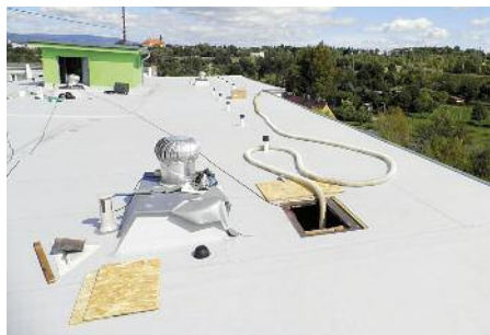
Izolování ploché střechy
