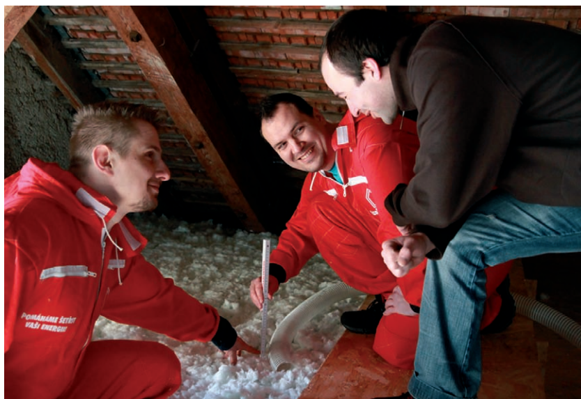
Pracovníci IP Polná ukazují zákazníkovi konečnou výšku izolace MAGMARELAX®
