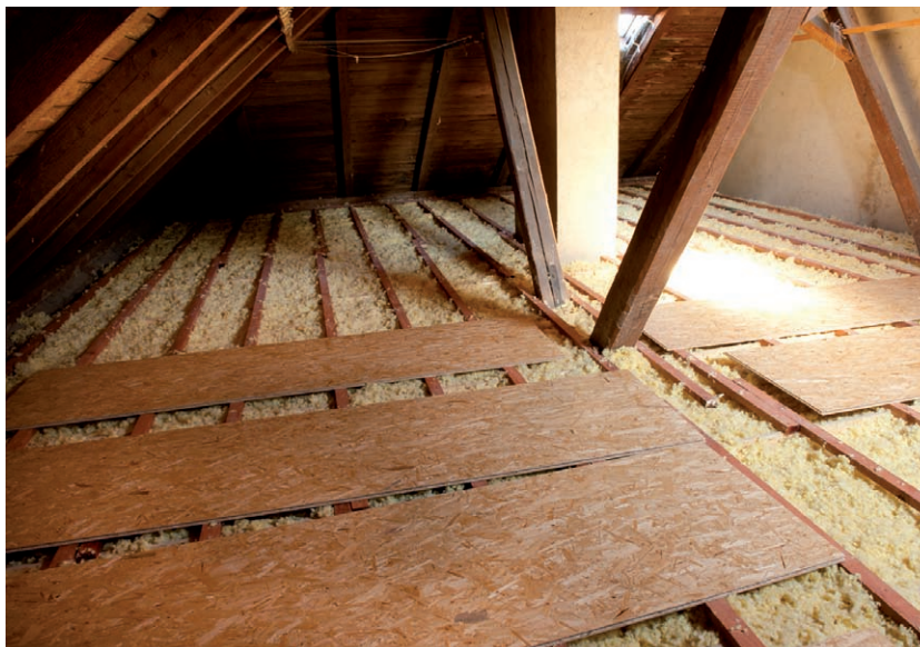
Stropní systém MAGMARELAX® zafoukaný minerální izolací
