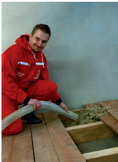
Vyplnění dutého stropu minerální izolací MAGMARELAX®
