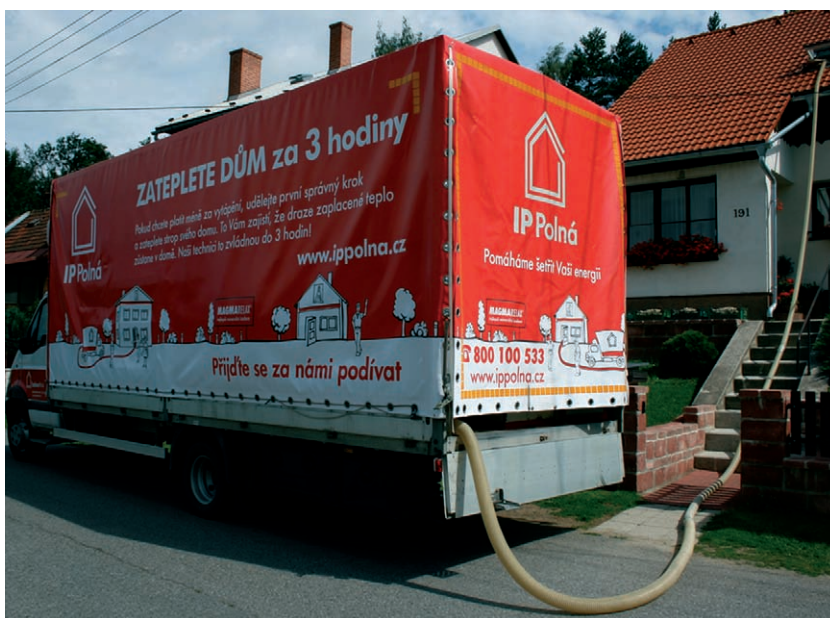
Minerální izolace se transportuje do domu přímo z auta
