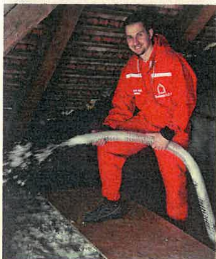
Foukání minerální izolace MAGMARELAX do půdního prostoru
