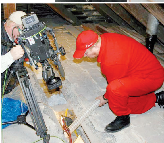
Při natáčení pořadu Rady ptáka Loskutáka – zateplení dutiny trámového stropu.
