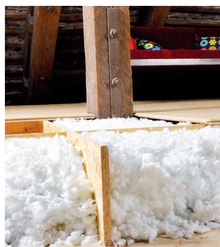
SSM stropní systém MAGMARELAX® - Pokud strop nemá dutinu lze snadno vytvořit novou podlahu s izolační vrstvou.
