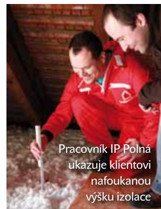
Vyplnění dutého stropu trvá 3 hodiny
