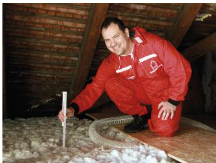
Pracovník IP Polná měří výslednou výšku izolace
