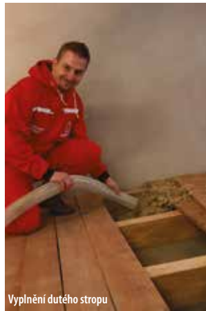
Vyplnění dutého stropu
