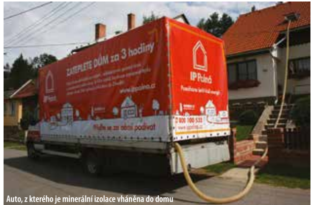
Auto, z kterého je minerální izolace vhnána do domu
