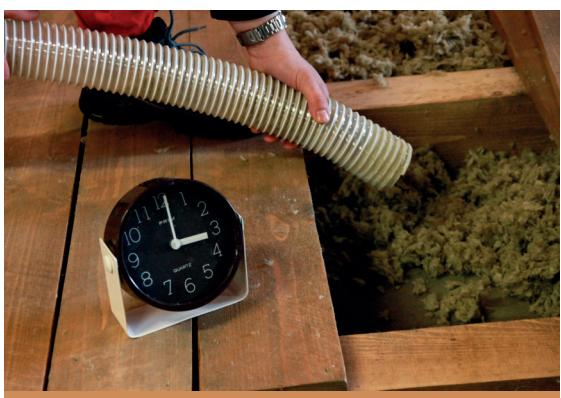
Není-li dutina v podlaze půdy k dispozici nebo je příliš nízká, nafouká se izolační vata přímo na podlahu půdy, stačí vrstva o síle 30 centimetrů. Ta již velmi dobře tepelně izoluje. Poměr ceny a úspory nákladů na topení zde vychází nejlépe. Půda však není jinak využitelná.
