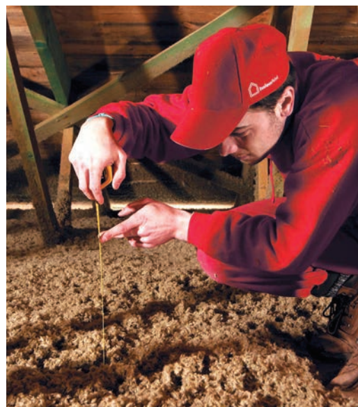
Závěrečná kontrola výšky izolace
