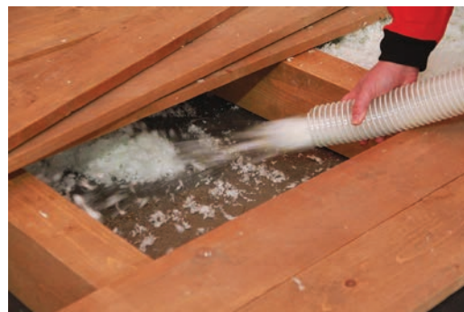
Foukání dutého stropu
