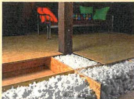
Nové řešení **Stropního systému MAGMARELAX®** zateplí podlahu půdy bez tepelných mostů a zároveň zachová dobré proudění vzduchu. Aby systém bezvadně fungoval, bylo nutno dokonale vyřešit mnohé technické detaily. Byly vyvinuty zcela nové typy odvětrávacích mřížek, lišť a speciálních průduchů. Tím se zamezilo srážení vlhkosti, tvorbě plísní a vzniku hnilioby.
