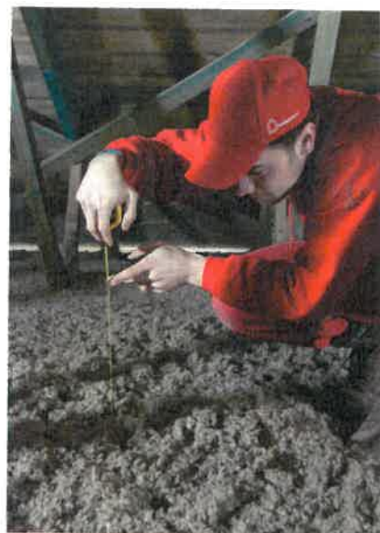
Kontrola výšky izolace
