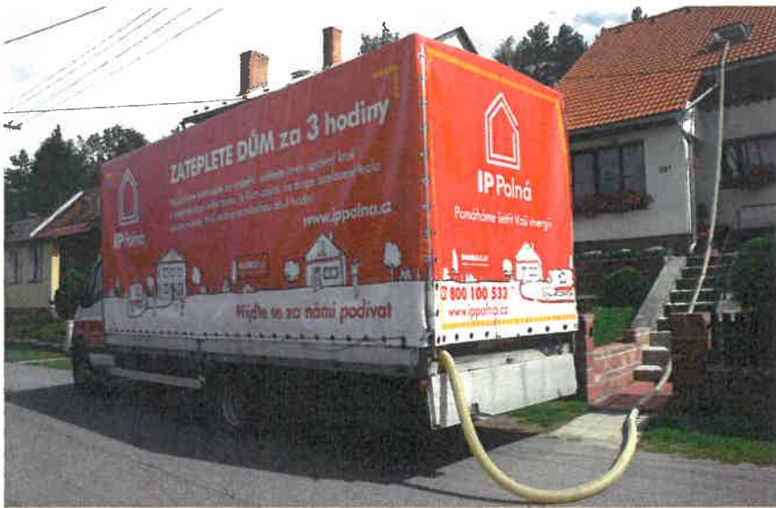
Auto, z kterého je izolace MAGMARELAX® poháněna do domu
