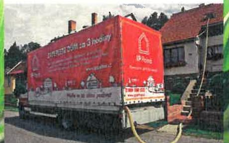
tři hodiny a izolační vrstva je jednolitá. Nejsou zde mezery, nevznikají tepelné mosty. Tím se v zimě dosahuje velkých úspor nákladů na topení. Právě stropem totiž uniká až třetina tepla. To je další obrovská výhoda nové izolované podlahy na půdě.
