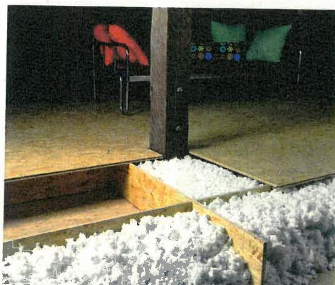
**MAGMARELAX,** ale tento systém je vhodný i na další typy střech. Například u složitých nepřístupných střech není třeba zasahovat do konstrukce, a přesto zajistíme dostatečnou vrstvu izolace i v nepřístupných místech. Jako jsou například vazivkové střechy.
